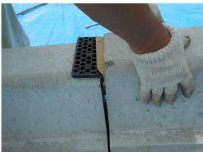
据付面よりわずかに浮かした状態で押すようにし、ゆっくりと接触する
