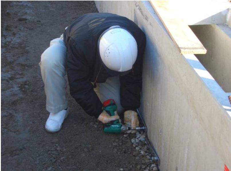
専用プレートを取付けします。写真のような工具があると作業効率が飛躍的に向上します。
