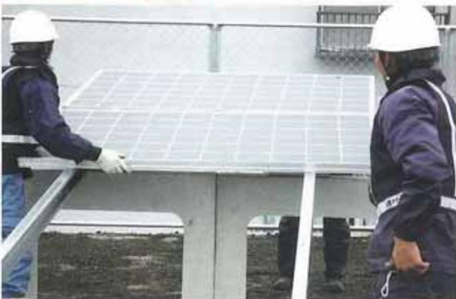
モジュールを取付け、受材を固定します。
