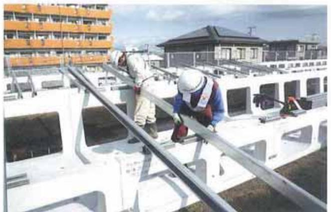
設計に合わせてレールアンカー取付け(後付けレールタイプのみ)、
