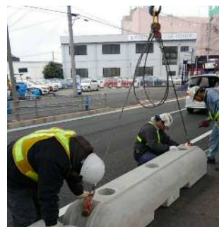
③吊上状況
