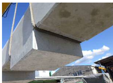
①吊上状況
