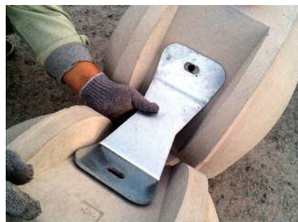
②プレート穴確認
