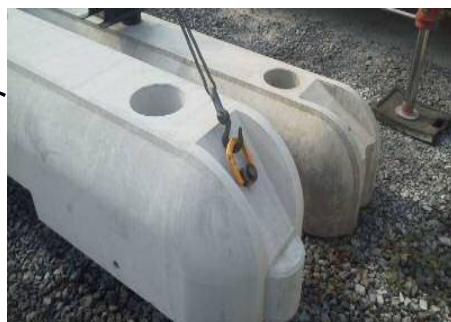
②吊り金具取付状況
