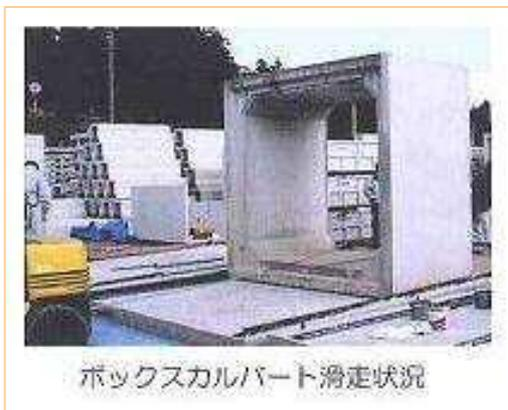
基礎コンクリートにレール(市販品鋼材)を埋設し、レール面へ勾配に影響されることなく偏りのない鋼球散布ができる粘着剤を塗布し、鋼球を介した上にコンクリート二次製品を配置する。そのコンクリート二次製品を牽引等で順次滑走させ移動し布設する工法です。
