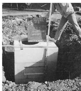
⑥ 本体（上部+下部）据付、GL再確認
