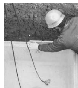
④ 本体（下部）据付及びレベル確認
