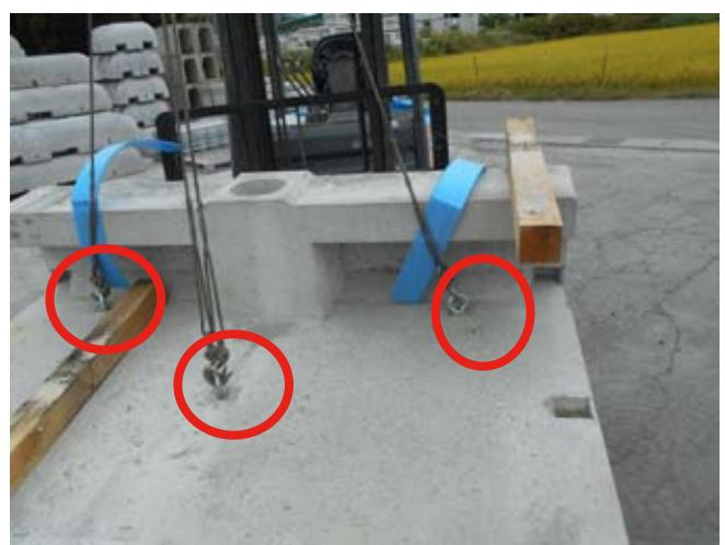
**STOP** 悪い例の写真のように吊り具で吊ると、製品が欠けてしまうことがあります。
