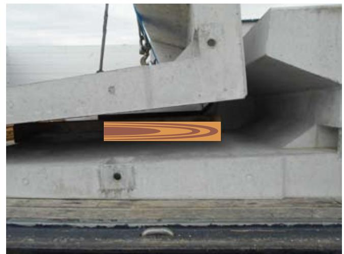
**STOP** 製品の手前の角に合わせて角材を置くと製品が欠けてしまう事がありますので少し奥に入れてください。
