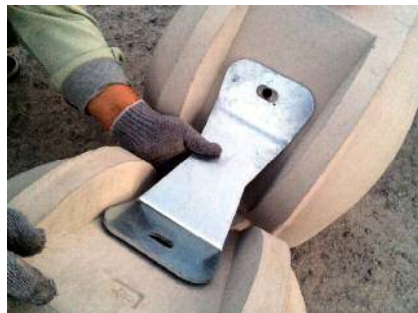
② プレート穴確認
