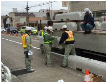
①吊上状況
