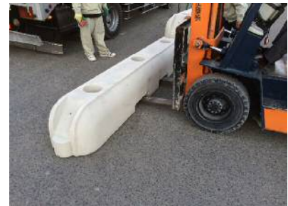
③リフト掬上状況
