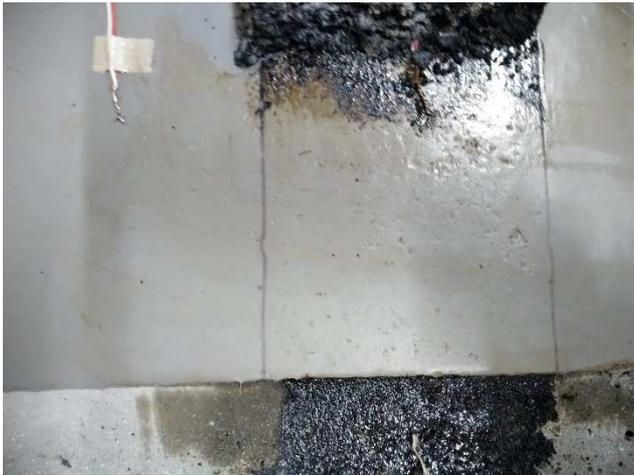
図-4 : 3cm 加熱アスファルト除去後
