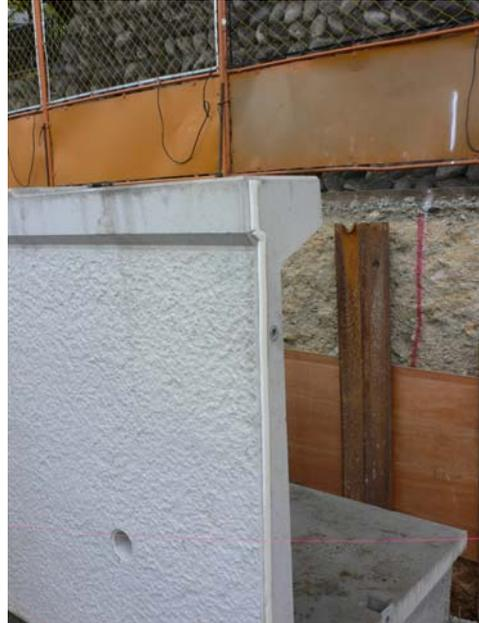
※擁壁高さが高くなると隙間も大きくなるため、状況により重ねるなどの方法で対応ください。
