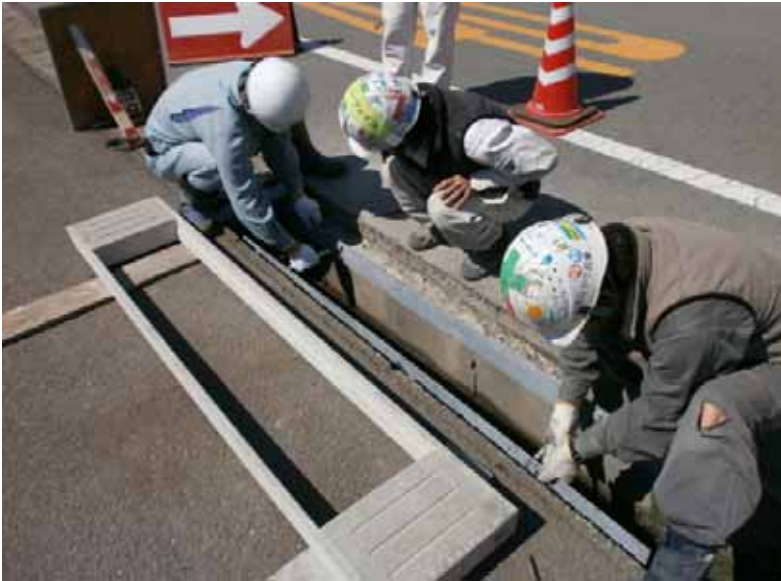
漏れ止め金具をセット
