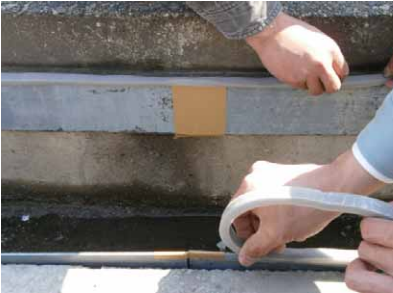
1次蓋の暗渠部の下部に隙間 テープを貼る
