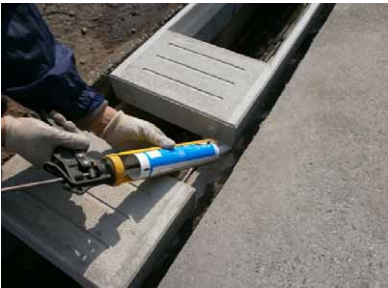
1次蓋の連結部にコーキング材を 塗布
