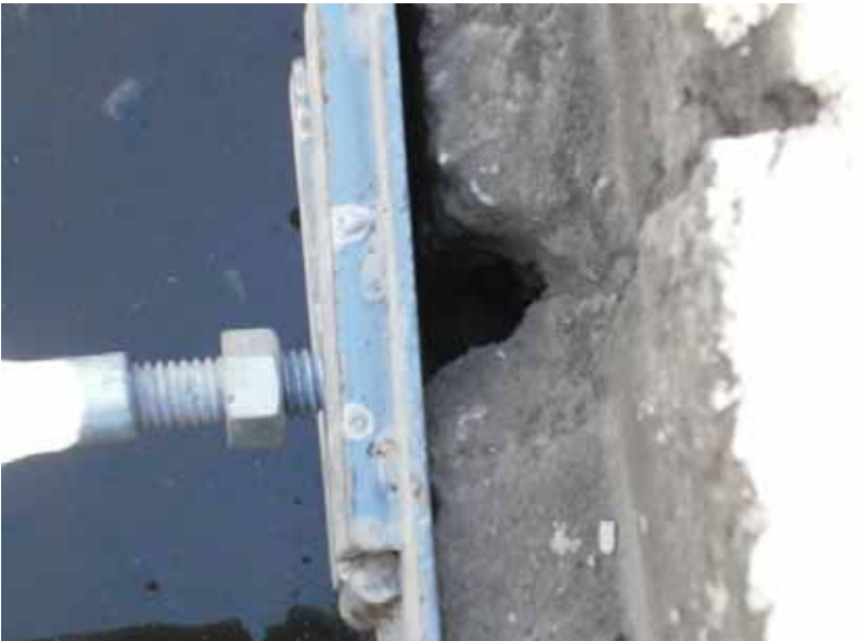
大きな隙間はモルタルで補修
