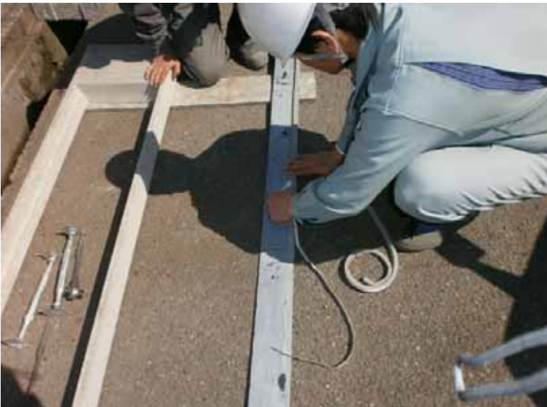
漏れ止め金具に隙間テープを 貼り付けます
