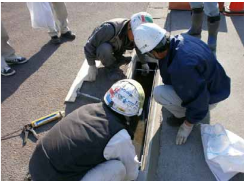
漏れ止め金具を撤去
