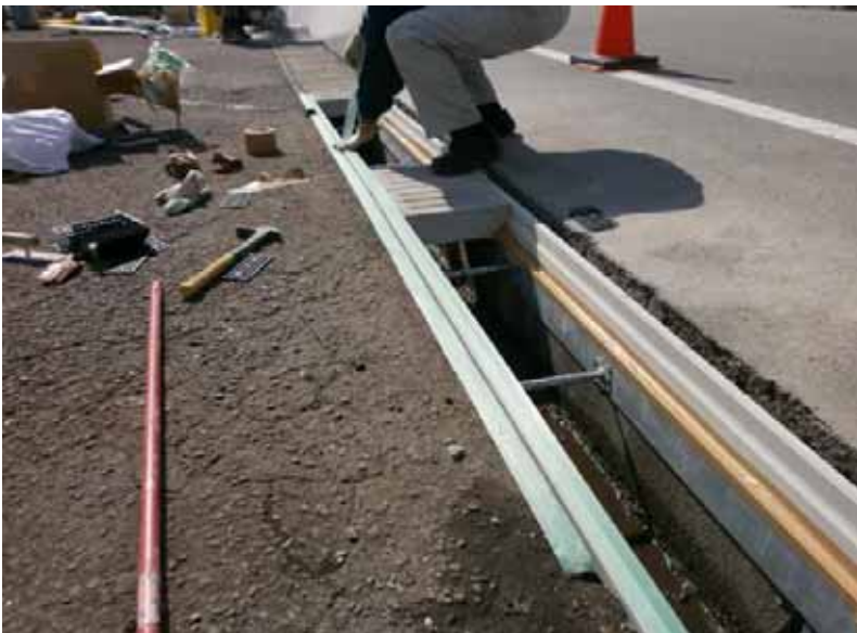
1次蓋と側溝の天端にマスキング
