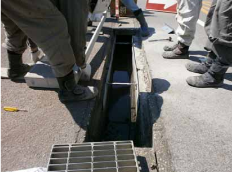
1次蓋をセットし高さを確認
