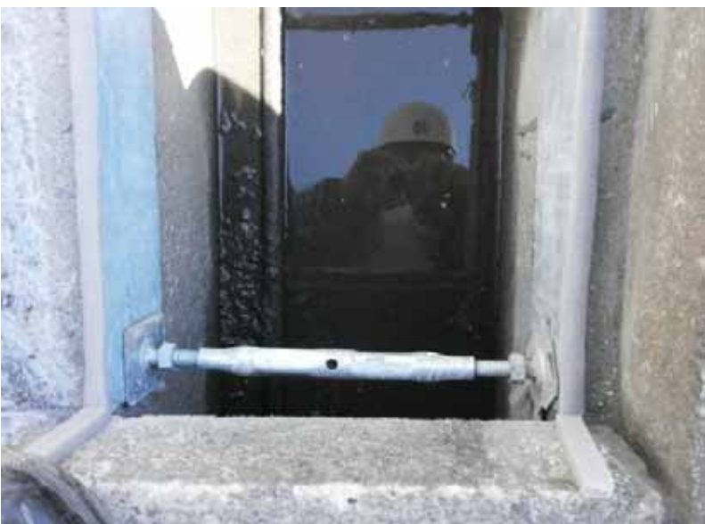
端部に隙間テープを貼り付け
