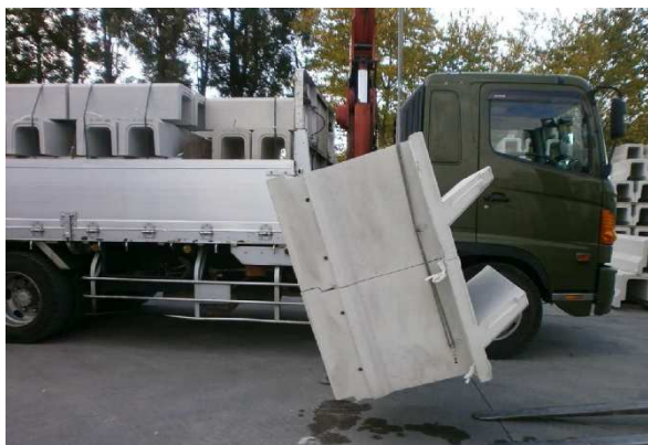
写真-1、配力筋利用方法
