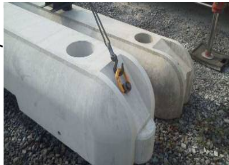
②吊り金具取付状況
