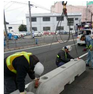
③吊上状況
