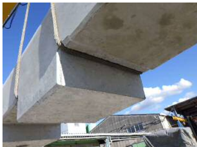
①吊上状況
