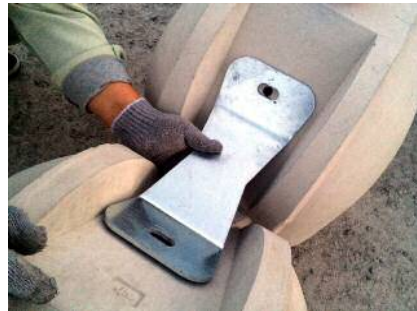
②プレート穴確認
